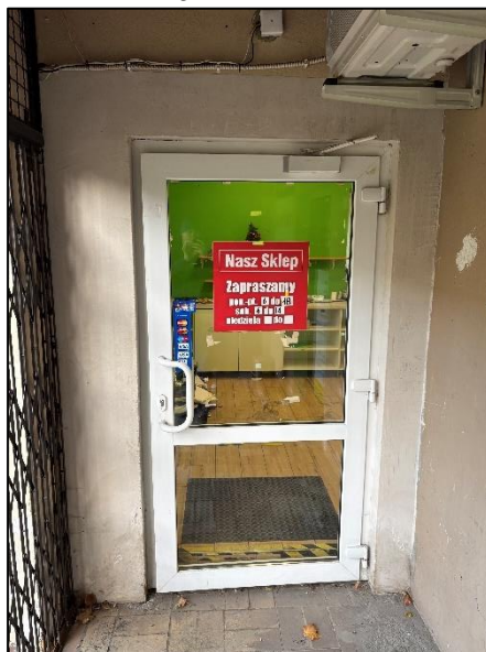
Drzwi wejściowe do lokalu
